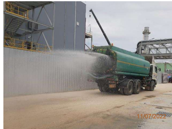
รูปที่ 2-7 รถบรรทุกน้ำฉีดพรมน้ำภายในพื้นที่ก่อสร้าง
