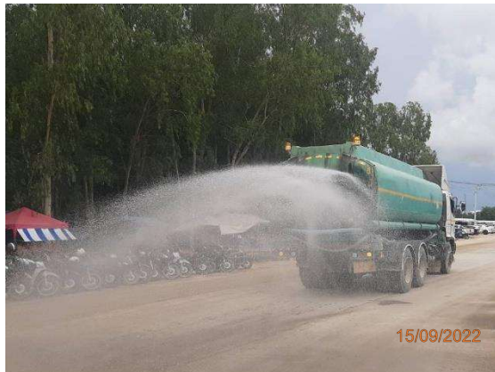
รูปที่ 2-6 รถบรรทุกน้ำฉีดพรมน้ำตลอดแนวถนนสาธารณะ โดยรอบพื้นที่โครงการ
