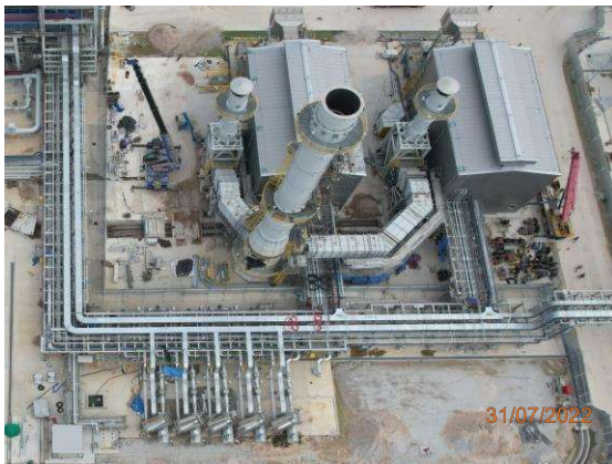
งานติดตั้งชุดปล่อยระบายอากาศ
