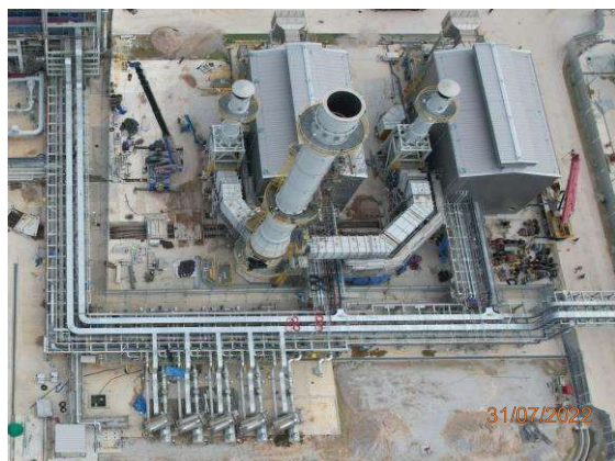
งานติดตั้งชุดปล่องระบายอากาศ
